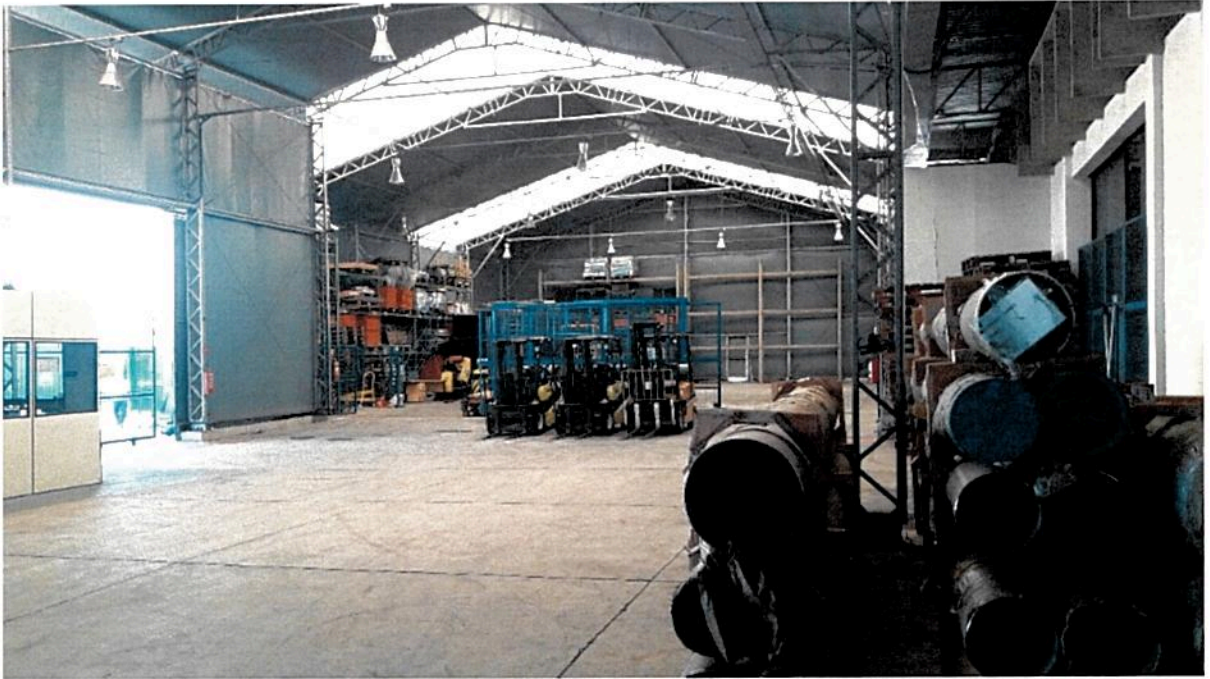
Figura 8 – Galpão de Lonado do Terminal de cargas – vista interna
