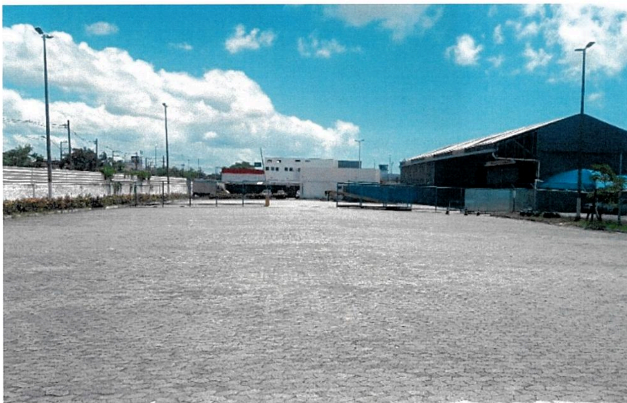
Figura 10 – Vista geral do pátio.
