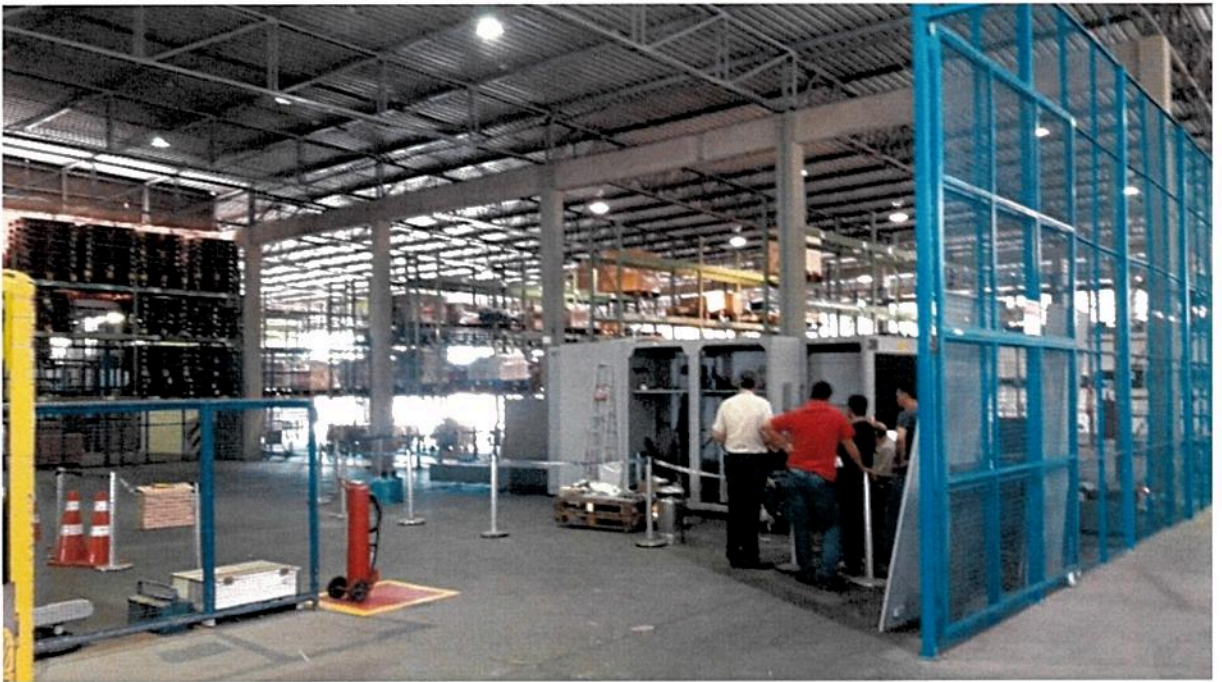
Figura 6– Galpão de armazenagem de cargas – vista interna
