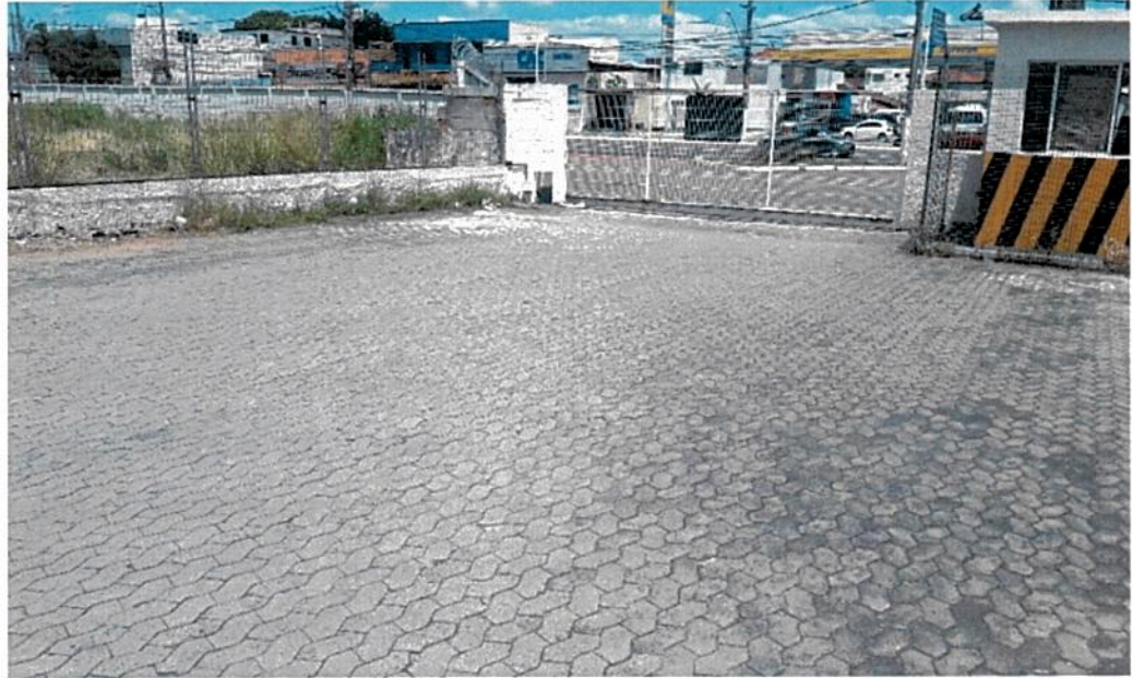
Figura 12 – Vista geral do pátio de descarga de caminhões
